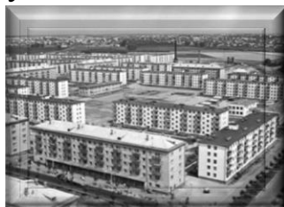
Рис.1. Массовая застройка 60-70х годов. «Хрущевки».
