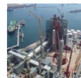
Рис.9. Демонтаж колонн нефтеперерабатывающего предприятия.
