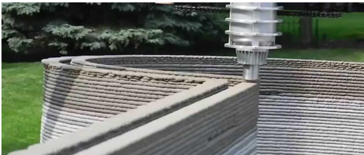
Рис. 2. Момент создания стены 3D-принтером
