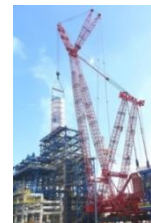
Рис.13. Монтаж коксовой камеры установки замедленного коксования.
