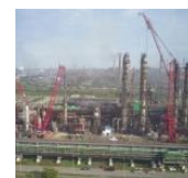
Рис.11. Демонтаж старой колонны.
